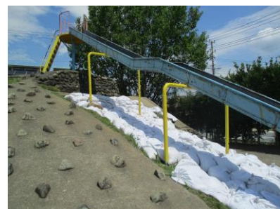
側溝の土を土のうにつめ、でこぼこだったなかよし山の斜面に。
